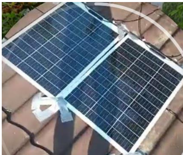
Рисунок 2 – Монокристалічні сонячні панелі, змонтовані на даху
