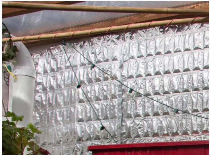
Рисунок 1 [5] – Приклад розміщення модулів з фазовим матеріалом на внутрішній стіні сонячної теплиці. Відбивні пакети, заповнені РСМ (парафіновою сумішшю), акумулюють сонячне тепло вдень і знижують тепловтрати через стіну вночі, підвищуючи нічну температуру повітря
