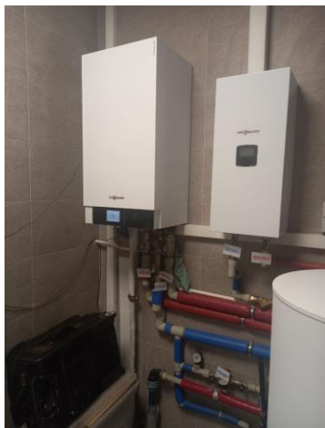
Рисунок 1 – Тепловий насос із відбором теплоти від зовнішнього повітря. Зовнішній вигляд, діаграма робочого діапазону
