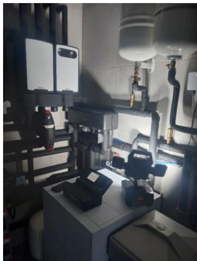
Рисунок 2 – Тепловий насос із відбором теплоти від ґрунту. Зовнішній вигляд, діаграма робочого діапазону
