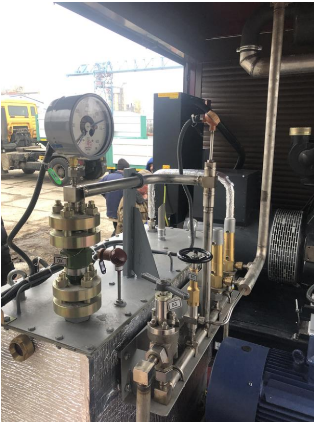
Рисунок 5 – Розташування відцентрового та поршневого насосів в установці ГУ-600/45
