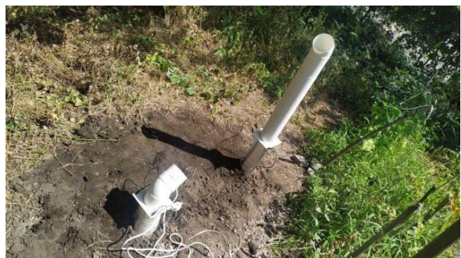
Рисунок 1 – Монтаж ґрунтового теплообмінника:
