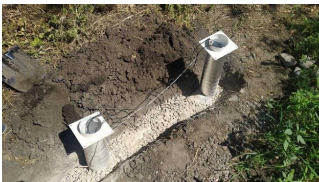
Рисунок 1 – Монтаж ґрунтового теплообмінника:
