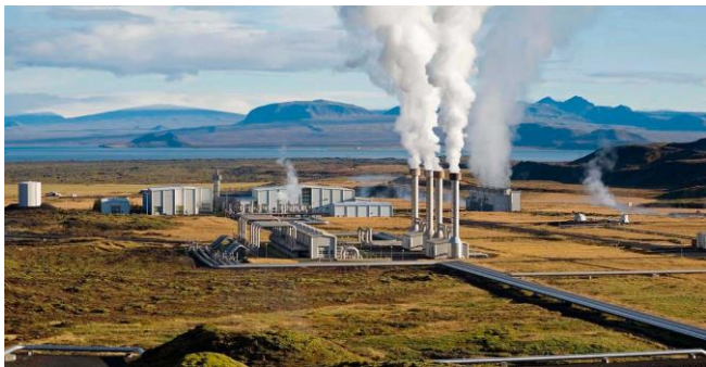
Рисунок 5 – Геотермальна станція, споруджена в Ісландії
